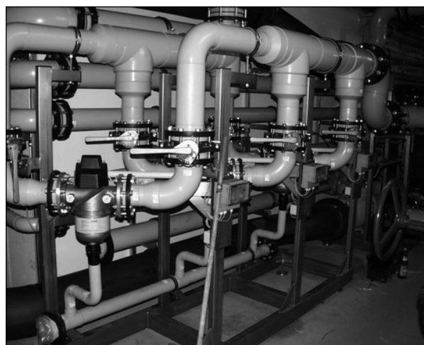
Figura 4 - Linea di processo industriale in PPR Figure 4 - Process pipe system out of PPR
